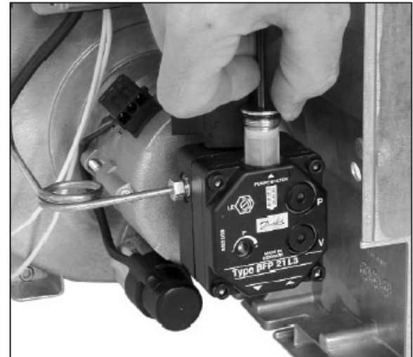
Рисунок 29 – Демонтаж топливного фильтра
